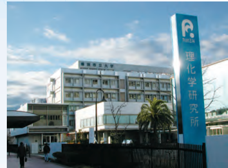
横浜市立大学実験棟(奥)と講義棟(手前)
